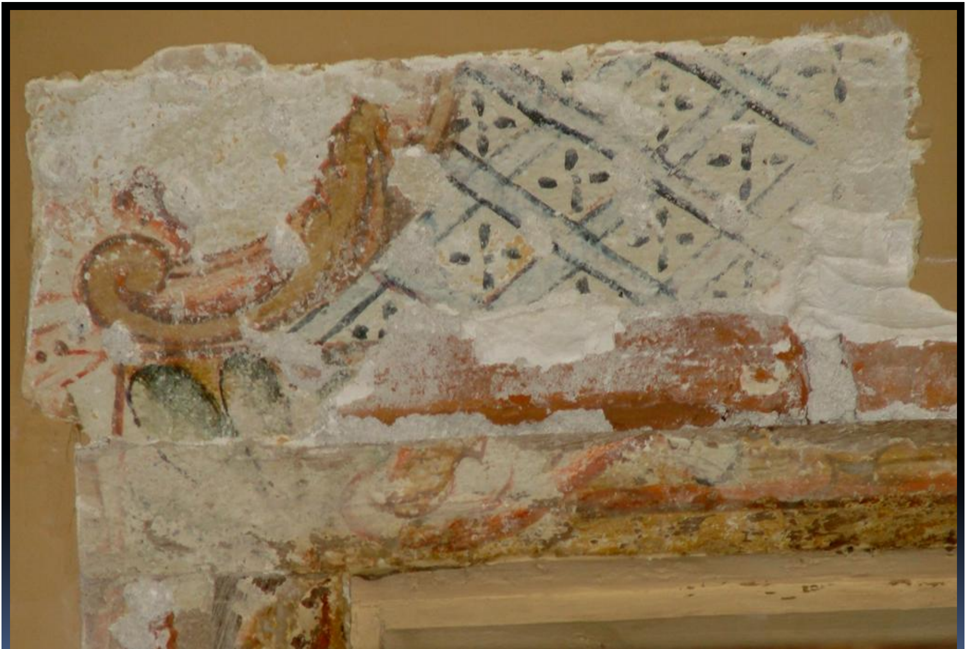
Catedral de Córdoba. Decoración de siglo XIX. Técnica de temple al agua. Muro de Nave norte.
